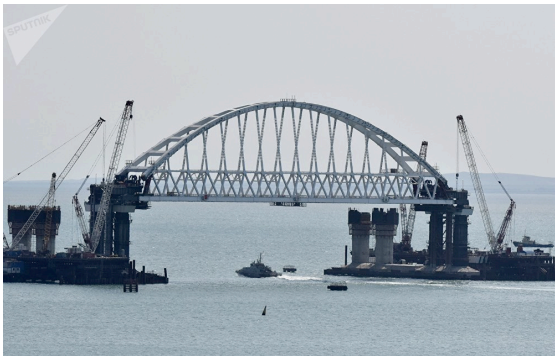
Un arche ferroviaire en voie de construction
